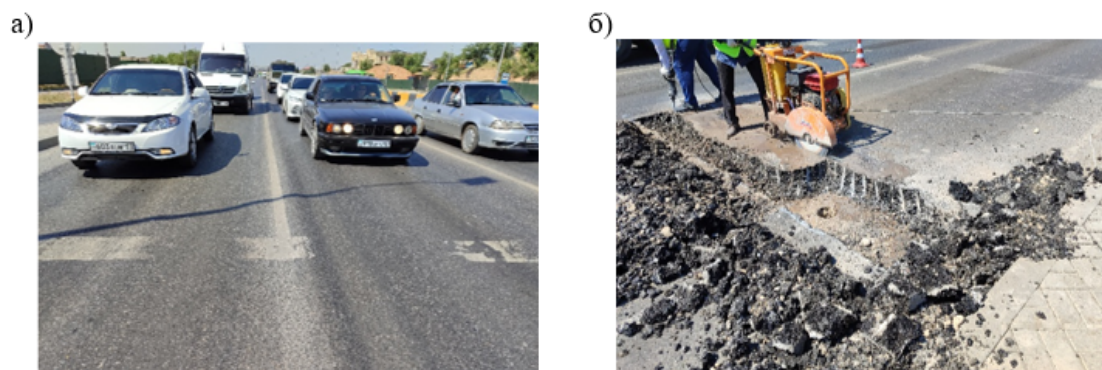
Рис. 1: Общий вид обследуемого участка (а); процесс вскрытия конструкции дорожной одежды (б)
